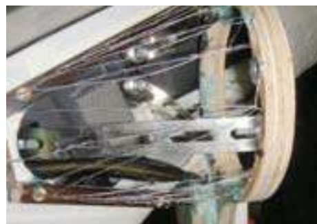
Крепление же — изогнутыми стальными стяжками к металлу стойки
